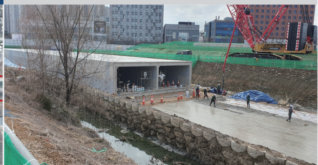
공법 : 벽체(DW), 슬라브 PC / 공사규모 : PC 3,649m³
