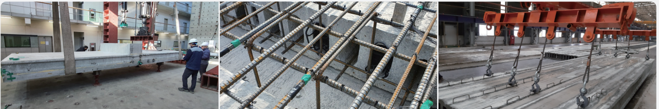
HCS 접합부 연속화 공법 / HCS 엔드 캡 / HCS 양중 고리
