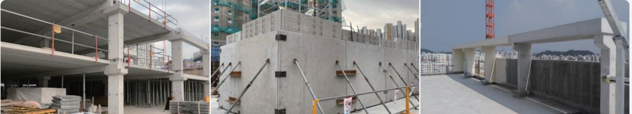
공동주택 구조물 | 지하주차장 / 지하외벽 / 주동하부 / 옥상조형물 등
