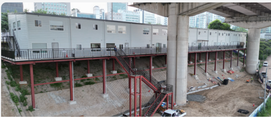
동부간선도로지하화(영동대로) 사무실 / 철판조 + HINGPANEL
