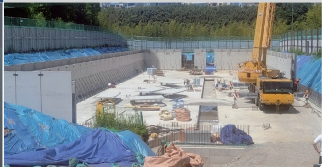
공법 : 기둥, 보, 벽체(DW), 슬라브 PC / 공사규모 : 1,672m³
