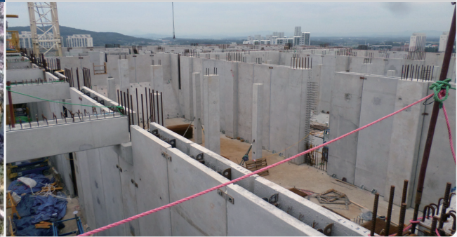
공법 : 기둥, 보, 벽체(DW), 슬라브 PC / 공사규모 : 188,667m³
