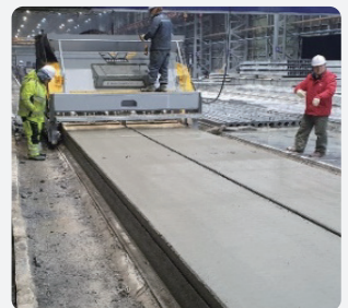
04 콘크리트 타설 및 성형
