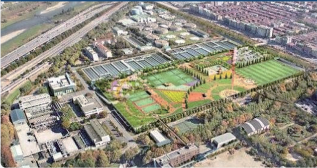
탄천 물재생센터 이전 현대화_수처리시설 PC 공사
