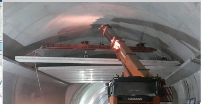
공법 : 벽체(DW), 슬라브 PC / 공사규모 : PC 3,649m³
