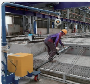
02 강연선 설치 및 인장
